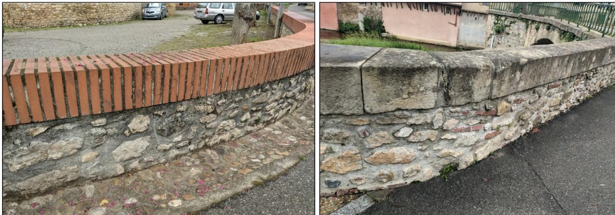
*Figure 13 : Exemple de finition de couronnement en rive droite actuelle du pont.*
