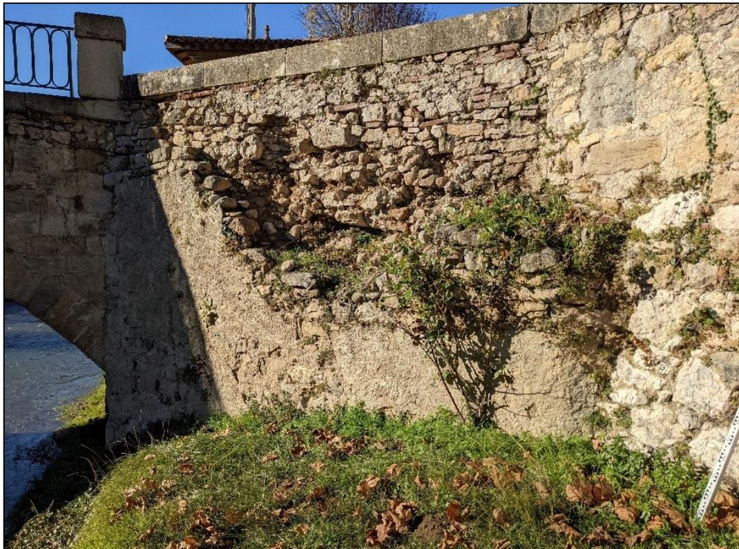
*Figure 25 : Mur de soutènement amont rive droite à reconstruire*
