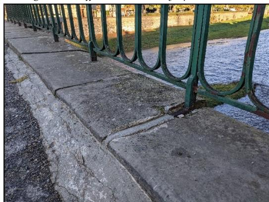
*Figure 13 : Détail réalignement des pierres et garde-corps*
