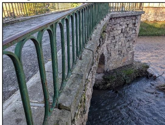
*Figure 11 : Effondrement du tympan amont V1*
