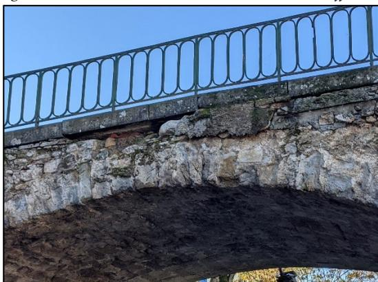
*Figure 10 : Effondrement du tympan amont V1*
