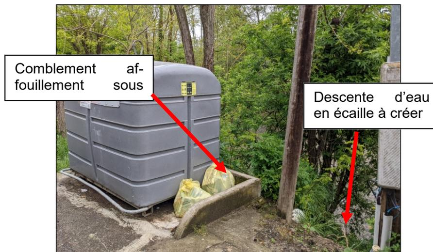
Figure 28 : Talus à reprofiler pour confortement de la dalle des containers poubelles
