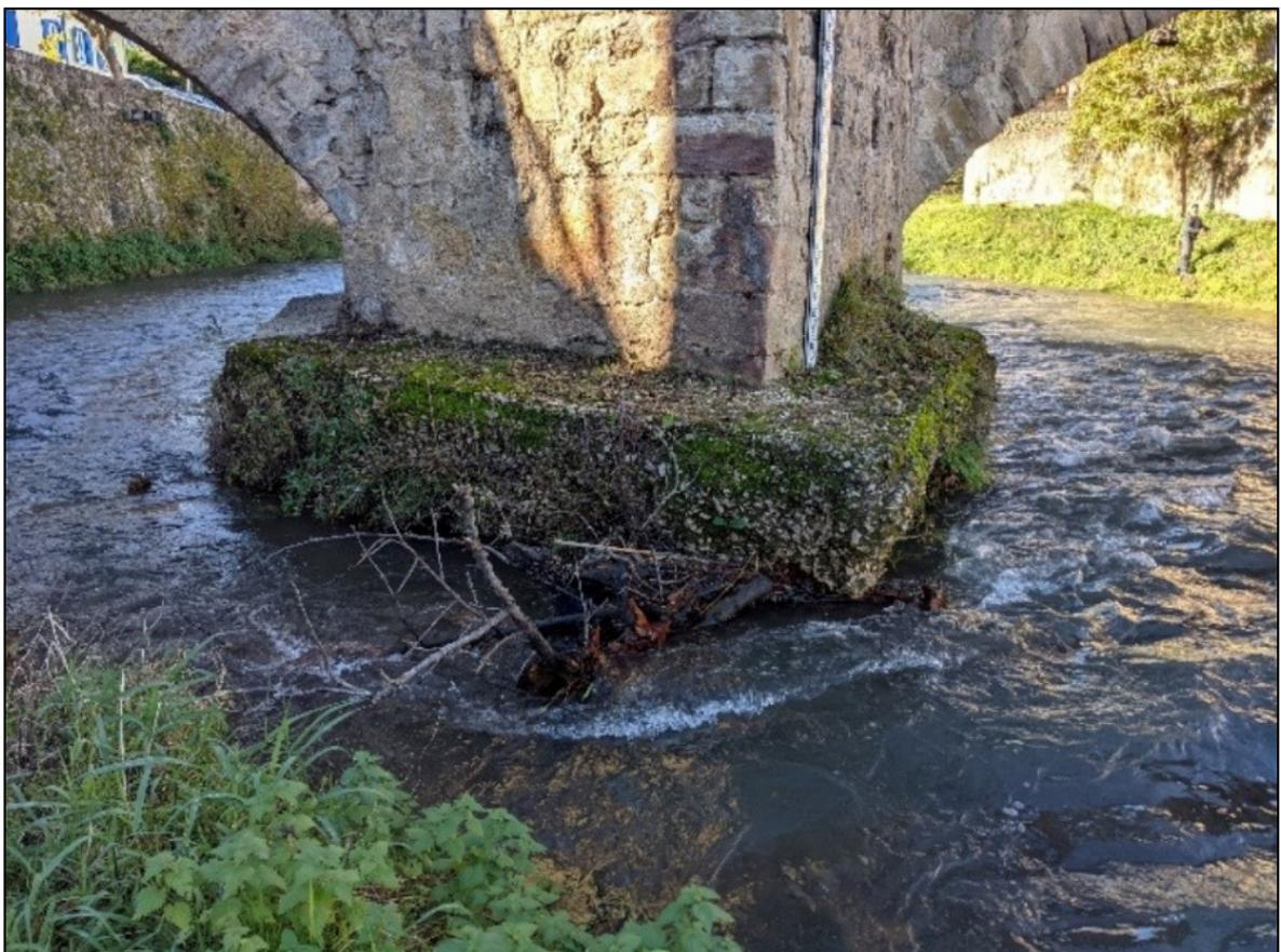
*Figure 26 : Vue amont du socle béton de protection de la pile*
