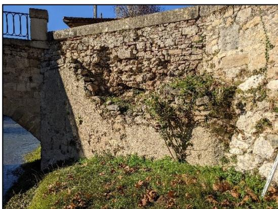
*Figure 8 : Mur de soutènement amont rive droite effondré*
