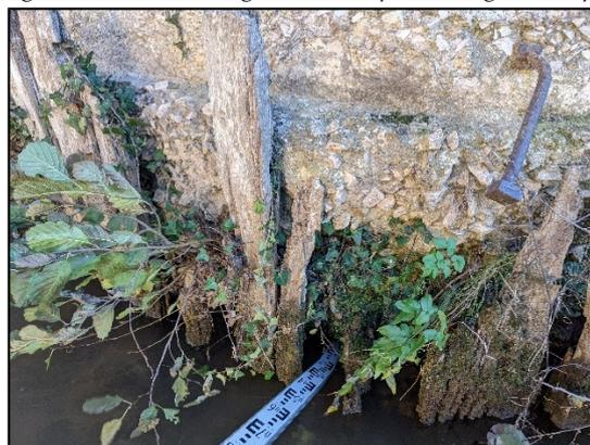
*Figure 15 : Affouillement socle béton de pile P1*
