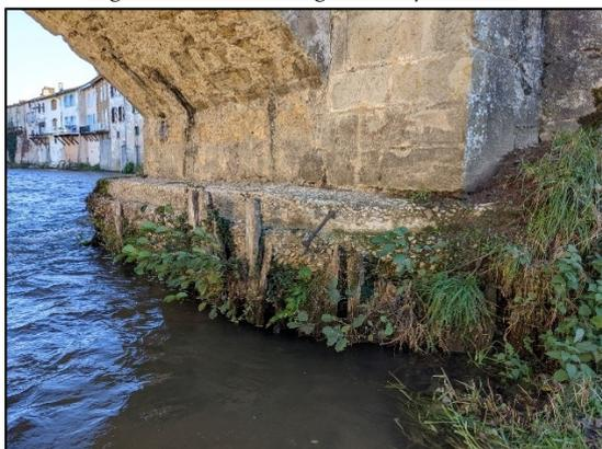
*Figure 14 : Affouillement socle béton de pile P1*
