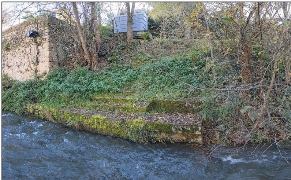
Figure 27 : Talus à reprofiler pour confortement de la dalle des containers poubelles
